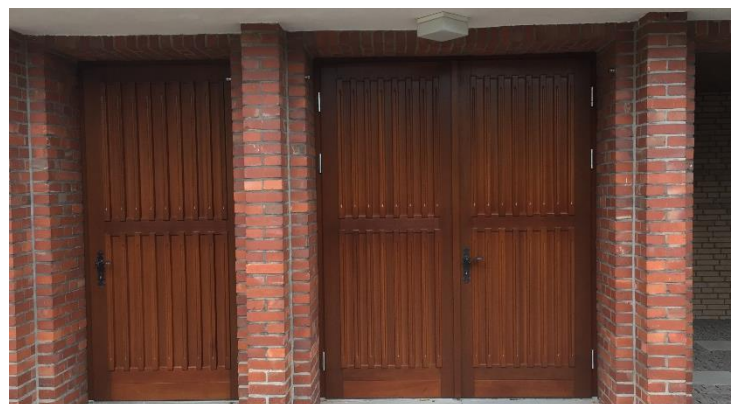
Die neuen Eingangstüren zum Kirchenschiff
